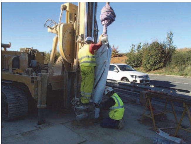
Figure 4. Descente d'un sac géosynthétique (21 octobre 2013).
