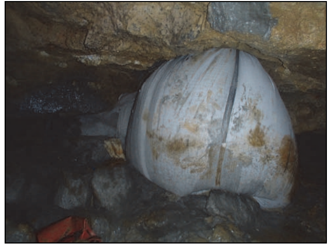
Figure 12. Conteneur M rempli au mortier (7 novembre 2013).
