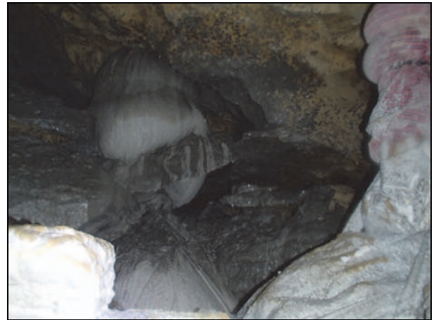
Figure 10. Chaussette extensible remplie de coulis (7 novembre 2013).
