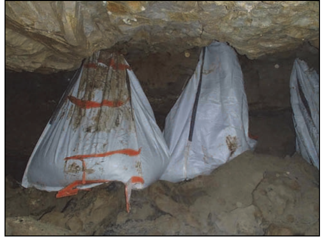
Figure 8. Repose du conteneur après remplissage du coulis de pose (10 octobre 2013).
