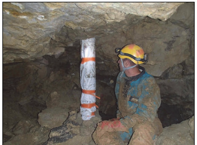
Figure 5. Sac géosynthétique en fond de cavité avant remplissage (9 octobre 2013).
