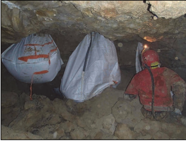
Figure 7. Conteneur relevé en cours de remplissage par le coulis de pose (10 octobre 2013).
