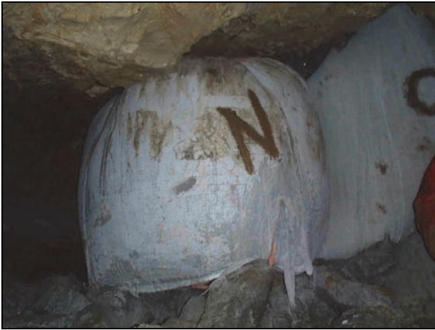
Figure 11. Conteneur N rempli au coulis (31 octobre 2013).
