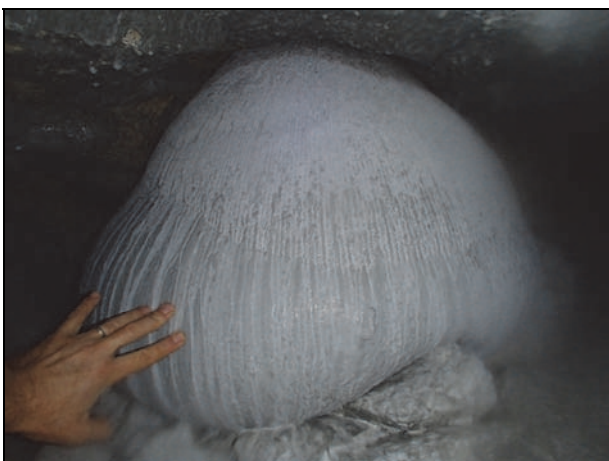
Figure 13. Gonflement de la chaussette dans la cavité (7 novembre 2013).
